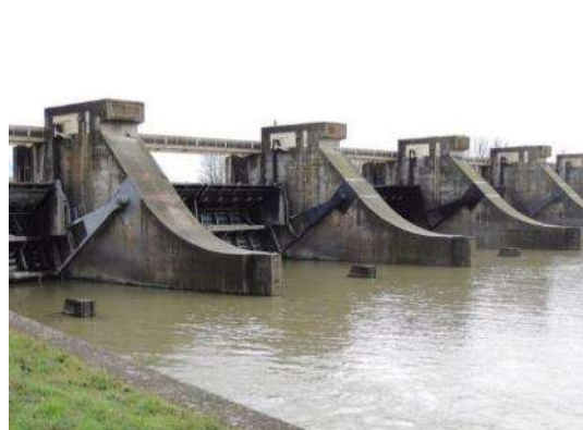
Photo 2 : Vue aval RD du barrage de Malause (source : malause.fr)
