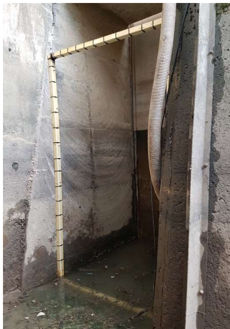
Photo 34 : Antenne GO20000 à l'entrée 2 de l'ascenseur
