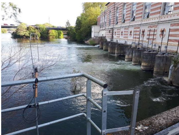
Photo 27 : Antenne aval (antenne boucle) installée à l'entrée de la passe à poissons de l'usine du Ramier
