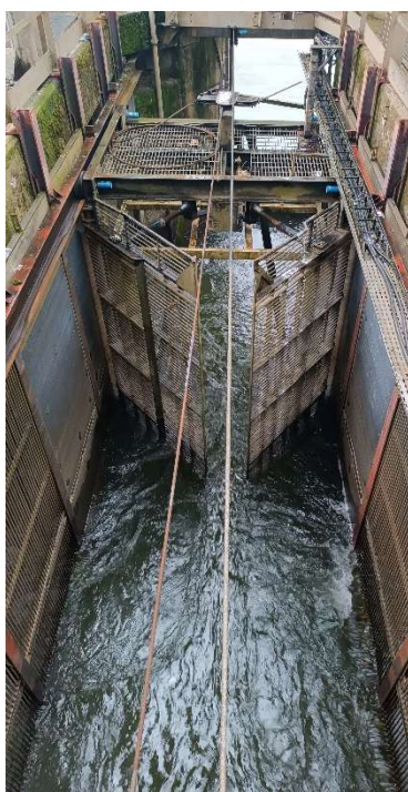
Photo 5 : Système de grille anti-retour du bassin de stabulation (amont)
