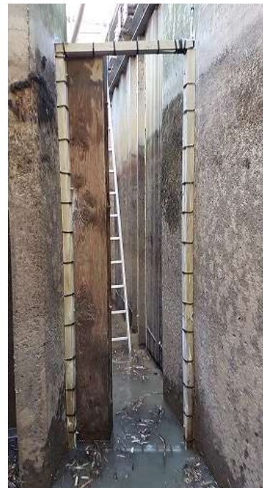
Photo 38 : Antenne BA20000 (vue depuis l'amont)
