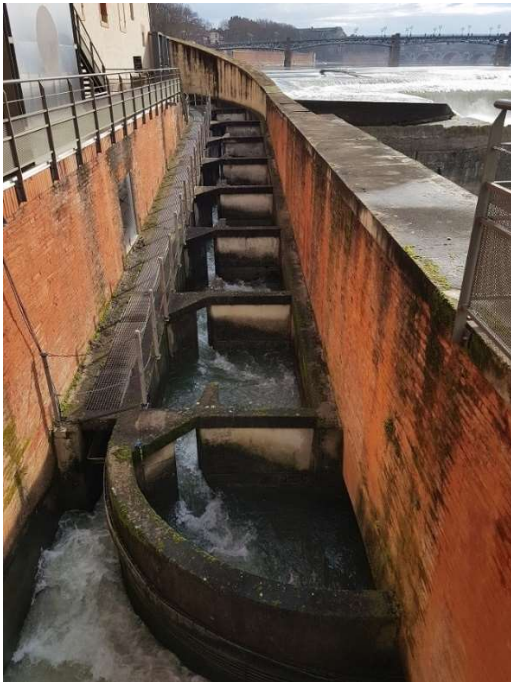
Figure 6 : Schéma d'implantation de la passe à bassins et de la passe à ralentisseurs du Bazacle (d'après DARTIGUELONGUE, 2019)
