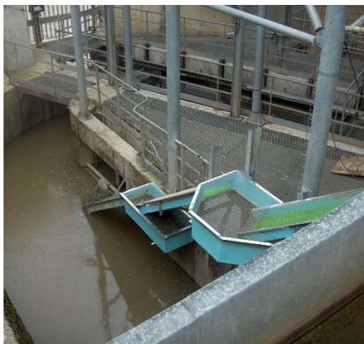
Photo 8 : Partie aval de la passe à anguilles
