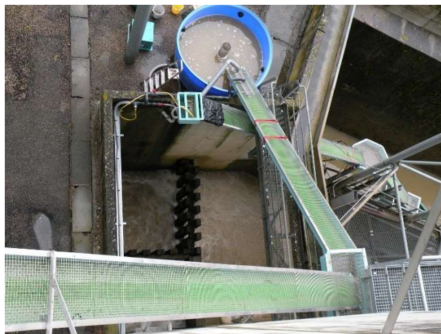
Photo 9 : Partie amont de la passe à anguilles
