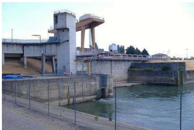
Photo 3 : Vue aval du barrage-usine de Golfech
