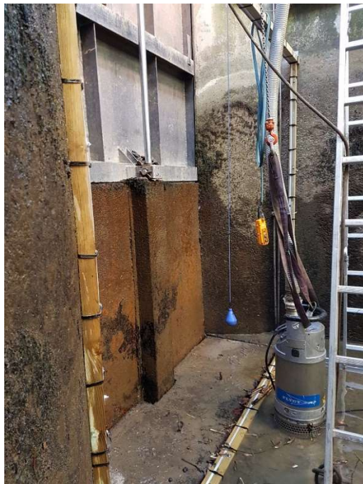
Photo 37 : Antenne BA10000, au niveau de l'entrée de la PAB
