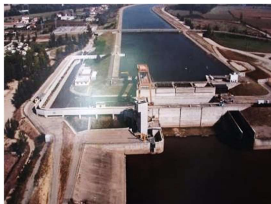
Photo 4 : Vue aérienne du barrage-usine de Golfech et du canal d'aménée (source : EDF)
