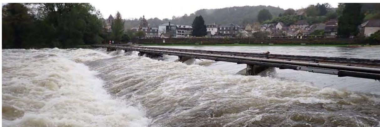
Figure 16 : Pelles du barrage des Aubarèdes abaissées le 04/11/2023 (Q=577 m<sup>3</sup>/s)
