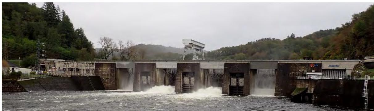
Figure 15 : Evacuation du débit par les vannes secteur au Sablier le 03/11/2023 (Q=375 m<sup>3</sup>/s).
