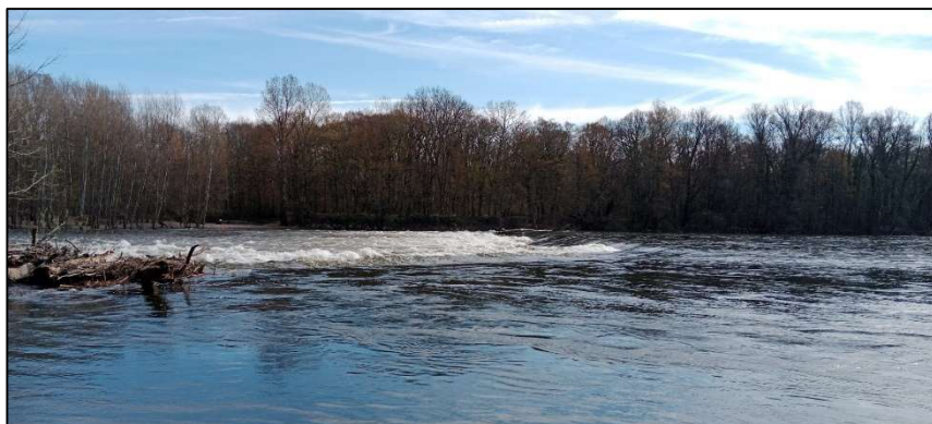
Figure 26 : Vu de l'amont du seuil de Carennac le 22 mars 2023 : débit 227m 3 /s
