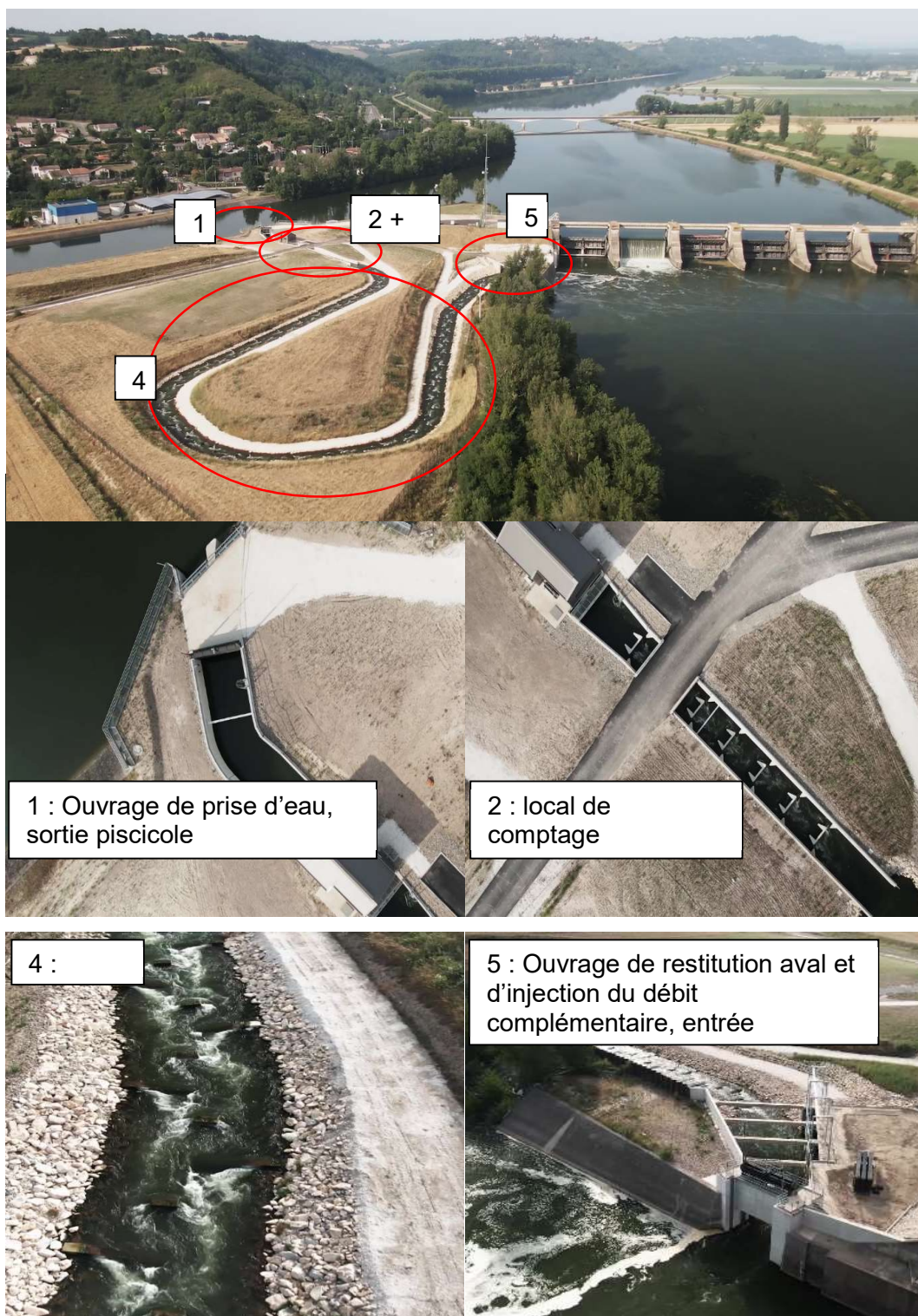
Figure 45 : Vue des différentes parties fonctionnelles de la rivière de contournement de Malause
