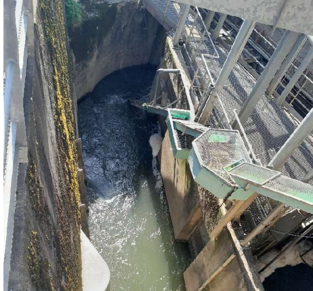
Figure 24 : Vue de la partie aval de la rampe à anguille, entrée 2 de l'ASP en service
