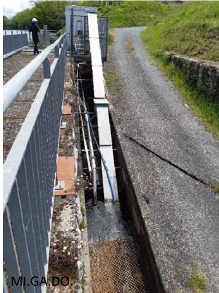
Figure 39 : Passe à anguilles installée sur le site de Tuilières en 2010.
