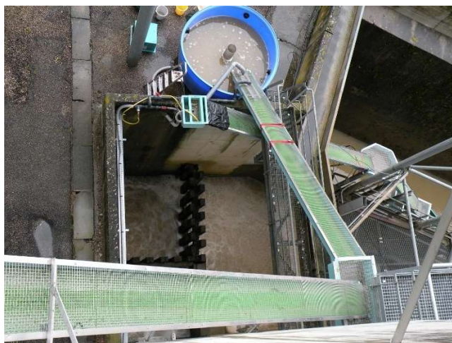
Photo 10 : Partie amont de la passe à anguilles
