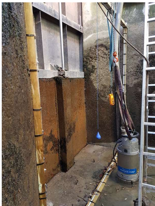
Photo 38 : Antenne BA10000, au niveau de l'entrée de la PAB
