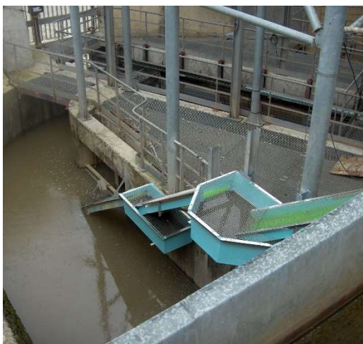
Photo 9 : Partie aval de la passe à anguilles
