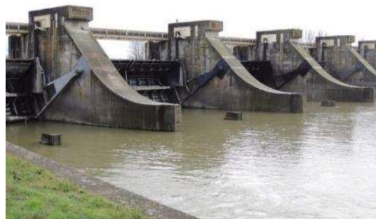
Photo 2 : Vue aval RD du barrage de Malause (source : malause.fr)
