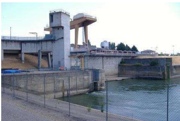
Photo 3 : Vue aval du barrage-usine de Golfech
