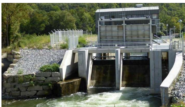
Photo 16 : Vue aval de l'aménagement de la Cavaletade (source : MJ2 Technologies)
