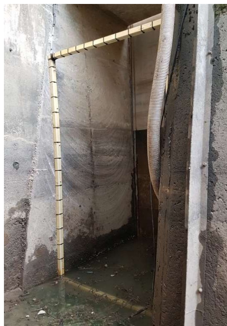
Photo 36 : Antenne GO20000 à l'entrée 2 de l'ascenseur
