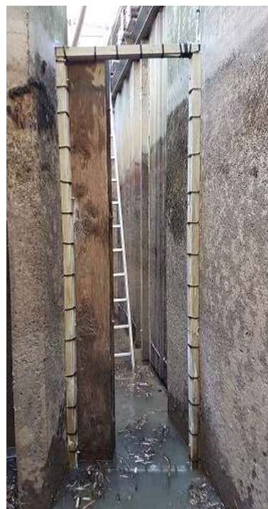
Photo 39 : Antenne BA20000 (vue depuis l'amont)
