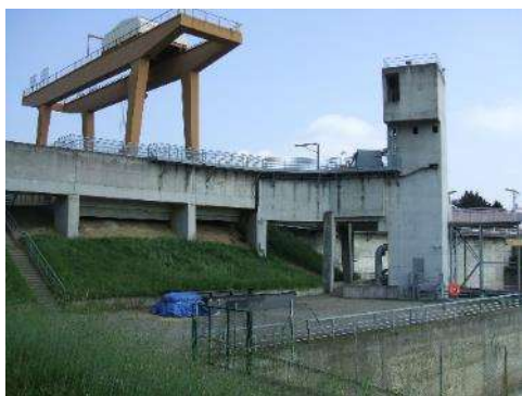
Photo 5 : Vue de l'ascenseur à poisson et du canal de transfert
