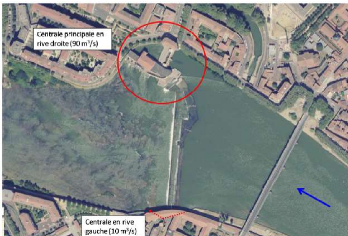
Photo 11 : Vue aérienne du barrage du Bazacle au cœur de Toulouse (source Géoportail)
