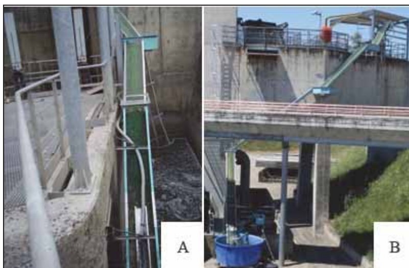
Figure 50 : La passe à anguilles actuelle de Golfech. En A, la passe partie aval, en B, la passe partie amont avec le bassin tampon (bleu).
